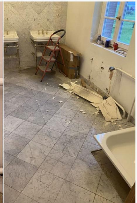
Die Bilder illustrieren das zweite Schadenbeispiel (S. 13): Das rechte Bild zeigt den Stuck, der an dieser Stelle von der Decke fiel und die Kappe traf. Das Ventil wurde dabei geöffnet. Links ist die Schadenstelle nach der Schadenfeststellung mit dem bereits montierten Thermostatkopf zu sehen. Die gerissene rote Bauschutzkappe liegt oberhalb des Thermostatventils auf der Fensterbank.
