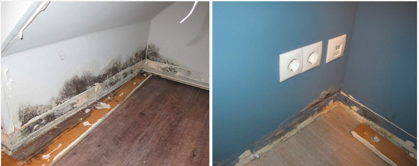
Das linke Bild zeigt Schimmelpilzwachstum unterhalb der Treppe zum Erdgeschoss in Wohnung 1. Rechts: Im Schlafzimmer von Wohnung 2 wurden die Fußleisten in einer Außenwanddecke entfernt. Auch hier ist deutlicher Schimmelbefall zu sehen.
