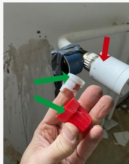
Der Thermostatkopf (roter Pfeil) wurde erst nach dem Schaden montiert. Vorher war auf dem Ventil nur eine zweiteilige Bauschutzkappe montiert (grüne Pfeile).
