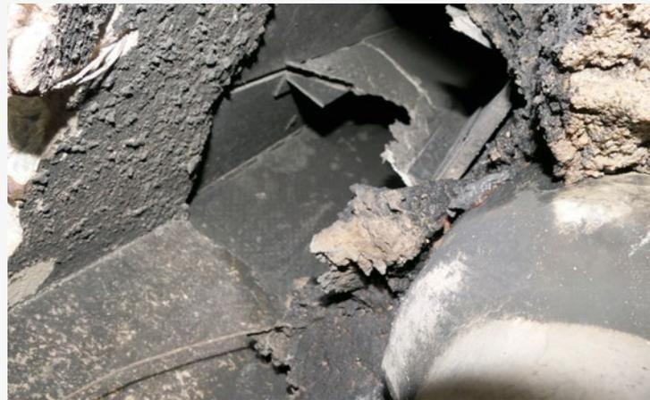
Der Abluftschacht, der hier im Müllraum mündet, besteht aus asbesthaltigen Faserzementformstücken.
