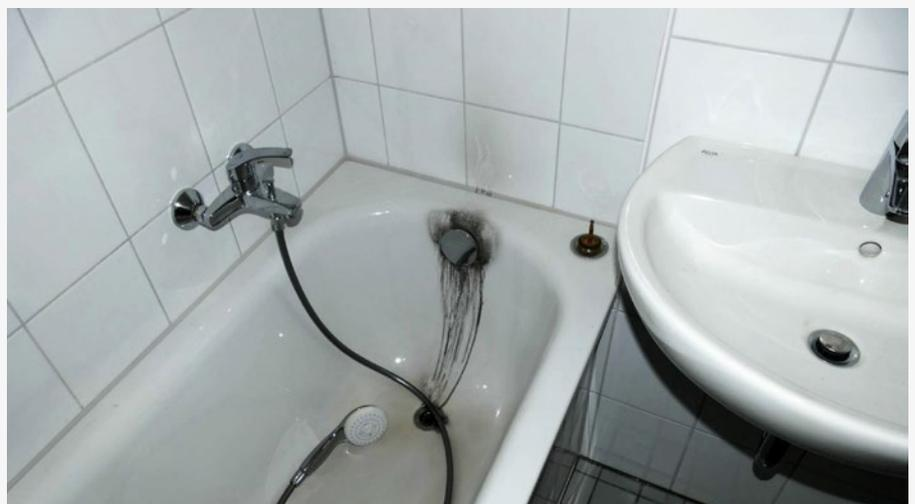
Die Rauchgaskondensate gelangten vom Müllraum zum Teil über beschädigte Abwasserleitungen in die Wohnungen.
