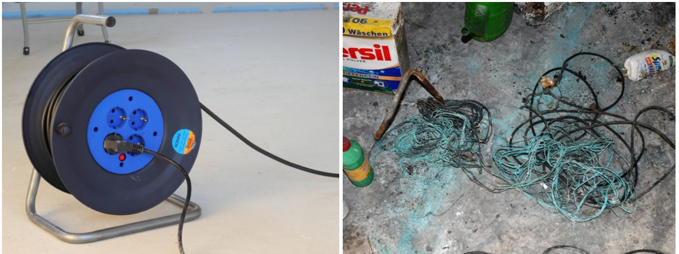
Die rechte Aufnahme zeigt die Überreste der Kabeltrommel aus dem geschilderten Fall. Der Trommelkern ist nicht mehr vorhanden und die Leitungsisolierung zu einem großen Teil verbrannt.
